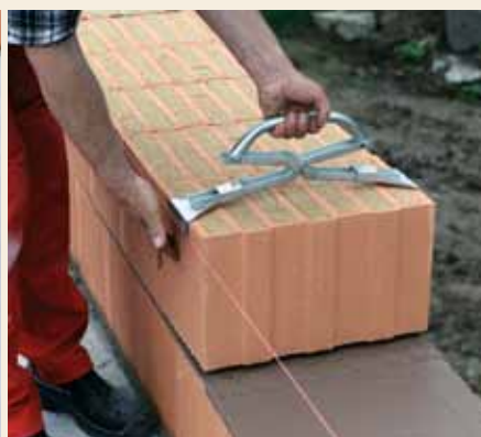
8. Wie gewohnt am Anfang und am Ende der Reihe einen Ziegel setzen und daran die Richtschnur anlegen. Dann Ziegel für Ziegel knirsch versetzen.
