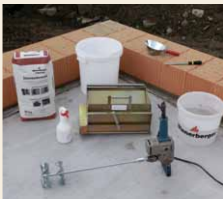
3. Material (gem. Wienerberger Produktprogramm): Dünnbettmörtel, Reinigungsspray (Trennmittel), Anrührreimer, VD-Mörtelrolle, Wassereimer, Doppel-Rührquirl, Schöpfkelle, Feile.
