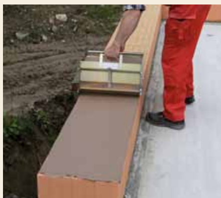
7. Schnell und einfach wird der Dünnbettmörtel auf die Ziegelschicht aufgetragen.
