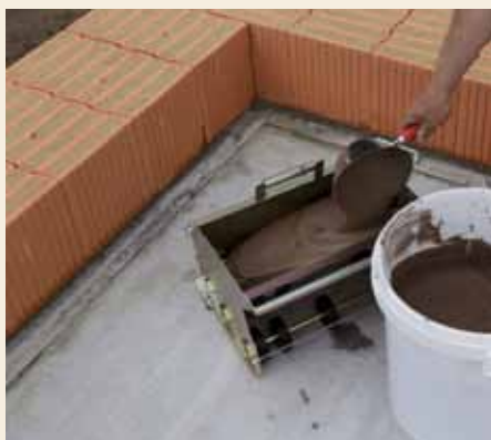
6. Jetzt wird die Mörtelrolle mit Dünnbettmörtel befüllt.
