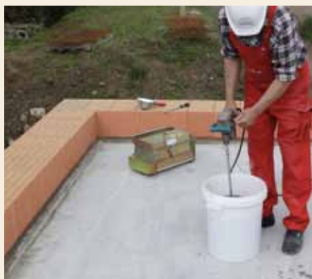
4. Dünnbettmörtel wie auf dem Mörtelsack angegeben mischen und anrühren.
