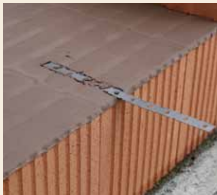
12. Vertiefen Sie zunächst die Lagerfläche der Ziegel an der entsprechenden Stelle mit einer Keramikfeile (Wienerberger Lieferangebot) um ca. 0,5 mm. Nach dem Aufrollen des Dünnbettmörtels werden die Flachanker an der vorbereiteten Stelle in das Mörtelbett eingelegt.
