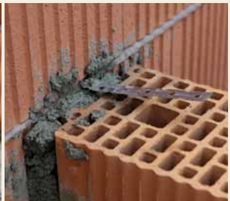
13. Innenwände werden Schicht für Schicht an die Außenwand herangemauert. Dabei müssen Sie die herausstehenden Flachanker in die Lagerfugen einbetten. Die Anschlussfuge muss satt vermörtelt werden (Mörtel bauseits, z. B. Quellmörtel).
