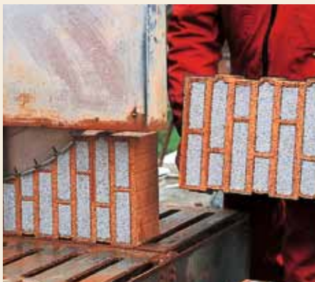
14. Schneiden gefüllter Ziegel mit der Nasssäge
