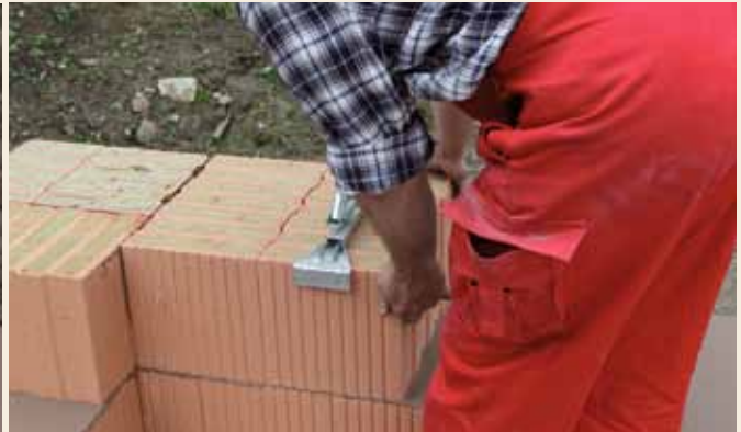
10. Weiter geht's nun in beide Richtungen mit normalen Ziegeln.
