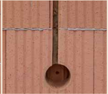
10.3 Das fertige Loch für ein Steckdose.
