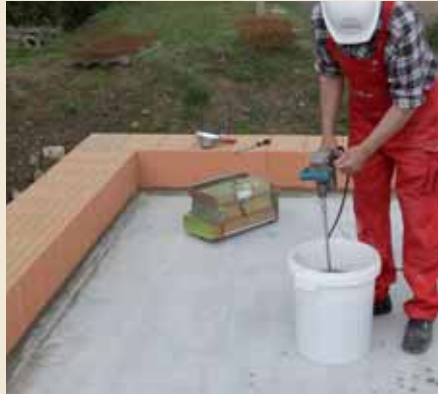
3.2 Dünnbettmörtel wie auf dem Mörtelsack angegeben mischen und anrühren.
