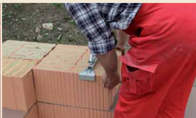
4.4 Weiter geht's nun in beide Richtungen mit normalen Ziegeln.
