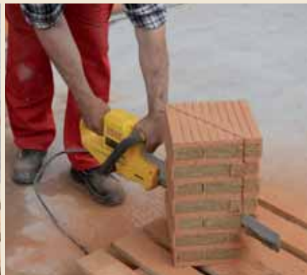
8.11 Trockenschneiden mit der elektrischen Handsäge.
