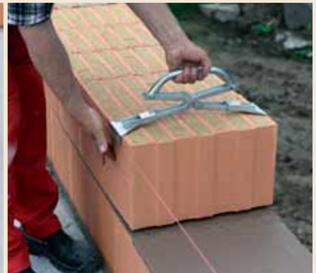
3.6 Wie gewohnt am Anfang und am Ende der Reihe einen Ziegel setzen und daran die Richtschnur anlegen. Dann Ziegel für Ziegel knirsch versetzen.
