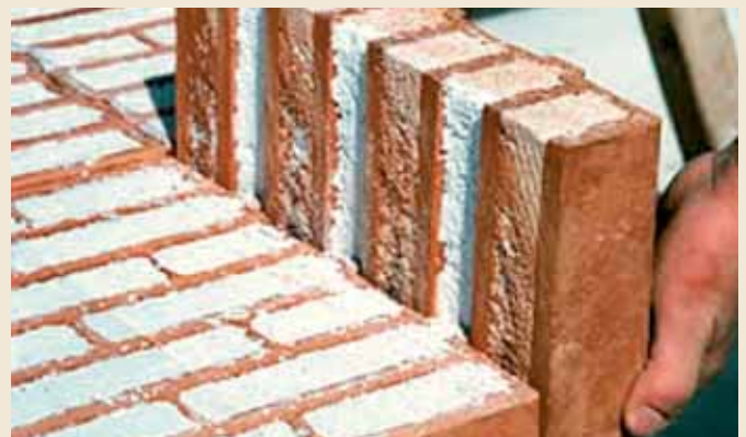
8.3. Ausgleichsziegel werden ohne Wärmebrücken versetzt.
