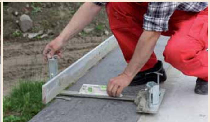
1.8 Danach eine Abziehlehre um Richtlattenlänge versetzen und neu justieren.
