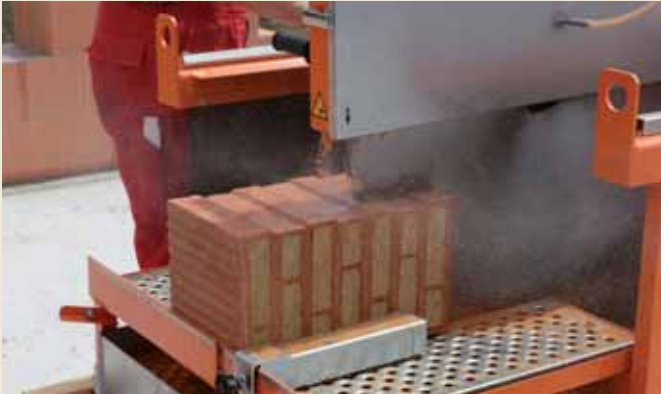
5.1 Höhenausgleich: Ausgleichsziegel mit der Nasssäge schneiden.
