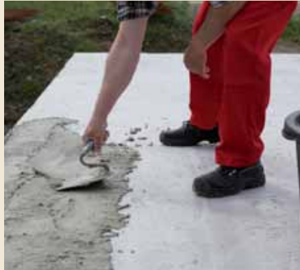
1.2 Im geplanten Wandbereich wird eine gleichmäßige dünne Mörtelschicht auf die Betonplatte aufgetragen.
