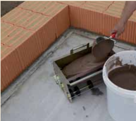
3.4 Jetzt wird die Mörtelrolle mit Dünnbettmörtel befüllt.
