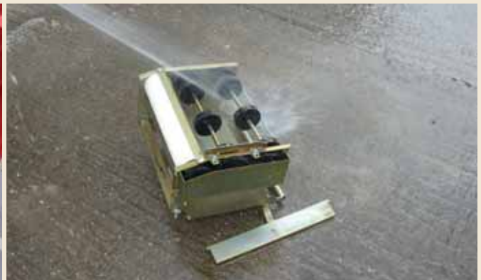
3.8 Nach Arbeitsende die VD-Mörtelrolle gründlich mit viel Wasser reinigen.
