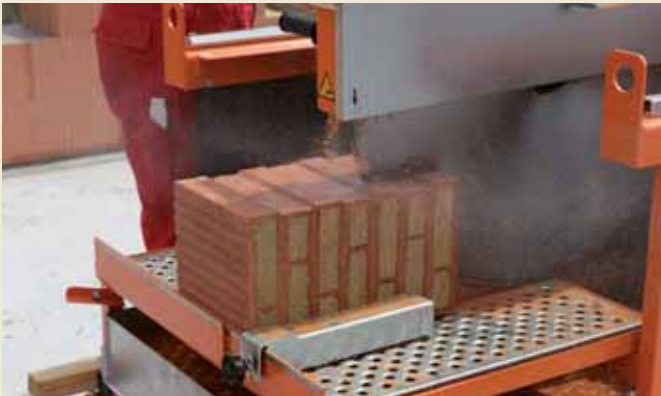
8.6 Mit der Nasssäge können Ausgleichziegel in beliebiger Höhe geschnitten werden.
