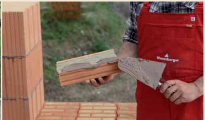
7.2 Die wärmegeämmte POROTON-Anschlagshale wird mit Dünnbettmörtel bestrichen...
