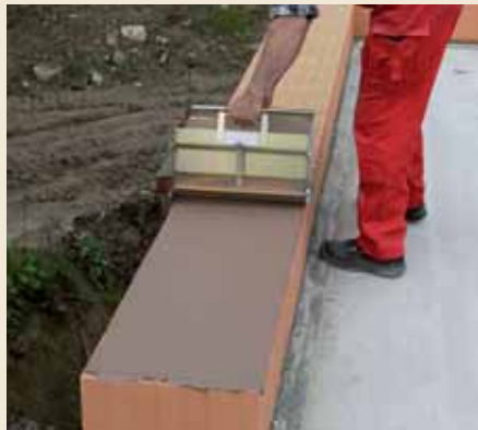
3.5 Mörtelrolle an der Ecke aufsetzen und ohne Druck über die Ziegel ziehen. So wird der Dünnbettmörtel schnell und einfach auf die Ziegelschicht aufgetragen.
