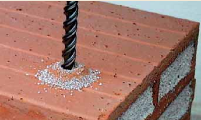
10.4. Perlitgefüllte Ziegel bohren.
