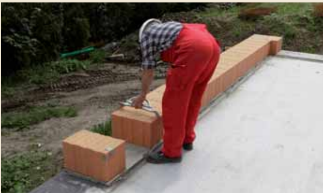
2.3 Ziegel für Ziegel knirsch versetzen.
