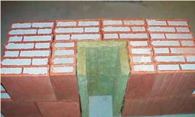
11.1 Schlitz für Abwasserrohr.
