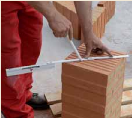
8.10 Sowohl für die Nasssäge als auch für die Handsäge werden die Schnitte angezeichnet.
