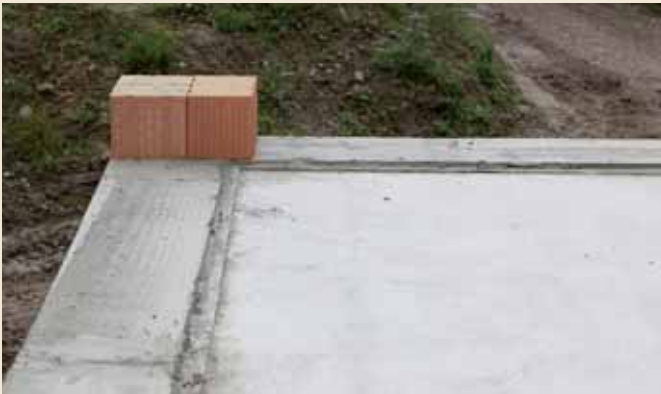
2.1 Die Ziegel werden in das noch frische Mörtelbett gesetzt. Sollte das abgezogene Mörtelbett bereits abgebunden sein, kann unmittelbar vor dem Versetzen der Ziegel eine Lage Dünnbettmörtel aufgetragen werden.
