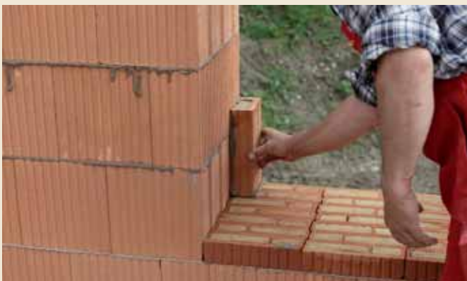
7.3 ... und angesetzt. Übrigens: Die Anschlagshale kann auch von unten an den Sturz angesetzt werden.
