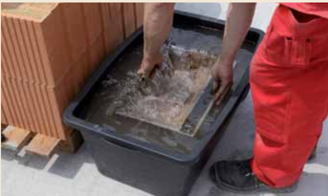
3.7 In längeren Arbeitspausen die leere Rolle im Wasserbad lagern. So trocknet der Mörtel nicht an. Wenn's wieder weitergehen soll, einfach das Wasser aus der Mörtelrolle schütten.
