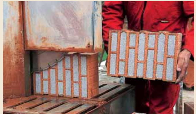
8.1. Schneiden mit der Nasssäge.
