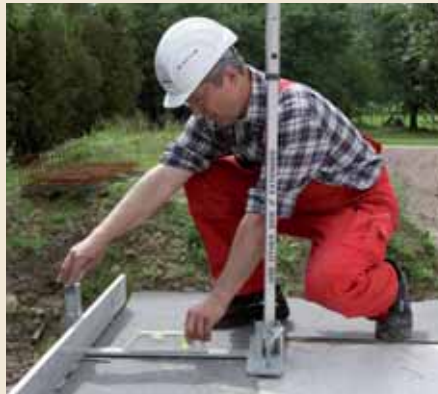
1.5 Den Justierboy (siehe Produktprogramm Wienerberger) aufbauen.
