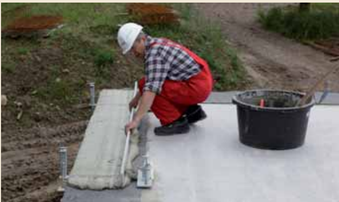
1.7 Mit dem Richtschieben den Mörtel auf den horizontalen Abziehlehren des Justierboys planeben abziehen.
