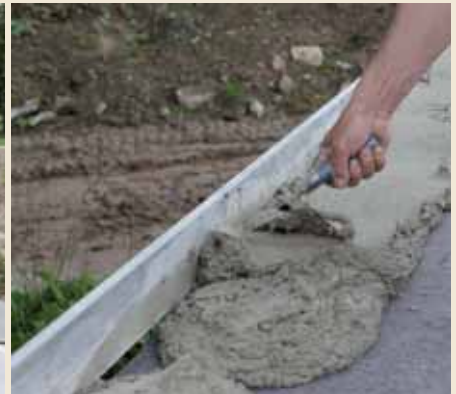
1.6 Vor dem Richtschieben Mörtel verteilen.
