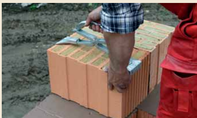
4.3 An die unverzahnten Seiten den ersten Normalziegel 42,5 setzen.
