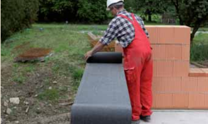
14.1 Bei Arbeitsende alle Mauerkronen abdecken.
