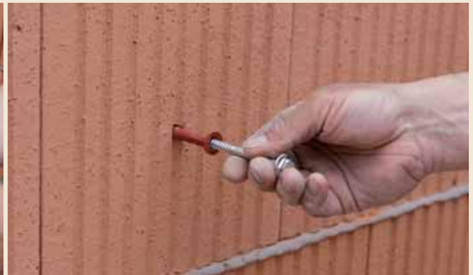
10.6 Dübel (ggf. bereits mit Schraube) ansetzen.
