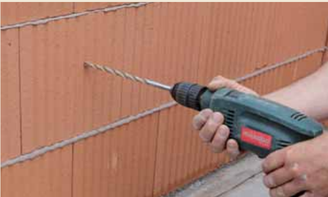
10.5 Bohren ohne Schlagfunktion mit scharf angeschliffenem Hartmetallbohrer.
