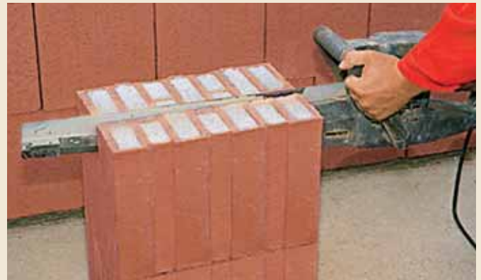
8.2. Trockenschneiden mit der elektrischen Handsäge (Alligator).
