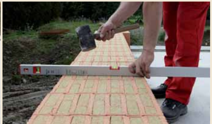
2.4 Anschließend mit Wasserwaage und Gummihammer ausrichten.
