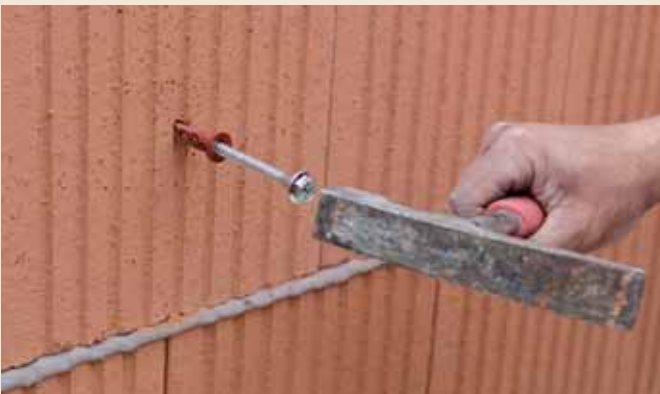
10.7 Dübel mit Hammer bündig einschlagen.
