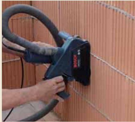
10.2 ... vertikales Schlitzen für Elektrodosen.
