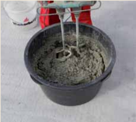
1.1 Anmischen des Mörtels (MG III) nach Herstellerangaben.
