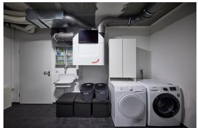
Bild 4: Um auf den 150 Quadratmeter Wohnfläche ein ähnliches Wohlfühlklima zu gewährleisten, wie es die nahezu unberührte Natur der nahen Umgebung hergibt, setzte das Bauherrenpaar auf eine innovative und intelligente Haustechnik - die komfortable Wohnraumlüftung.
