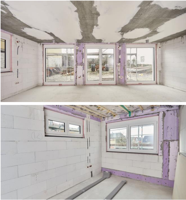
Bild 5 + 6: Bereits vor Baubeginn war klar, dass das neue Zuhause über eine zentrales Komfort-Lüftungsgerät verfügen sollte. Dadurch konnten die einzelnen Komponenten der Luftverteilung während der Bauphase ohne nennenswerten Mehraufwand verlegt und eingebaut werden.
