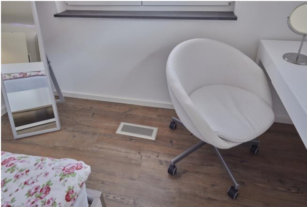
Bild 8: In den Zulufräumen strömt die frische und gefilterte Luft lautlos und ohne wahrnehmbare Bewegung ein. Zum gesunden Luftaustausch ist also kein Fensteröffnen nötig.
